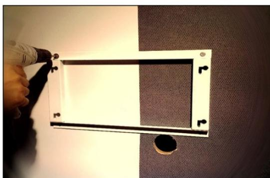
Percez des trous de 8 mm dans le mur ou le plafond et insérez-y les chevilles correspondantes. Pour les cloisons en placoplâtre, veuillez utiliser des chevilles MOLLY (non fournies dans la livraison). Une installation au plafond doit être réalisée par un professionnel. Nous nous dégageons de toute responsabilité en cas d'installation non conforme aux normes en vigueur.
